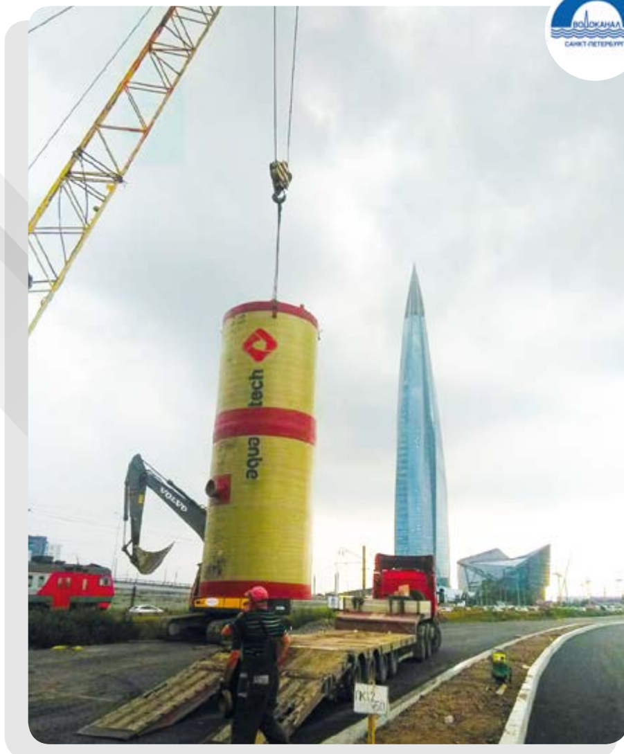
Объект: г. Санкт-Петербург, ул. Южная Оборудование: Канализационная насосная станция марки «АКВАТЕХ»
